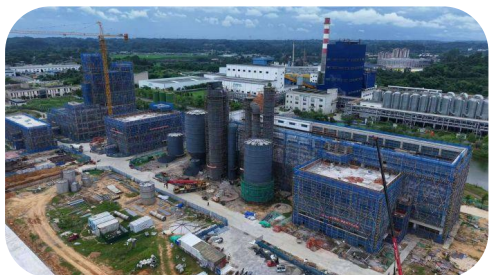
斑布健康竹产业园特种竹纤维功能性项目建设现场
