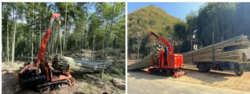
注：左图为林内竹材吊运；右图为场外装车转运。
